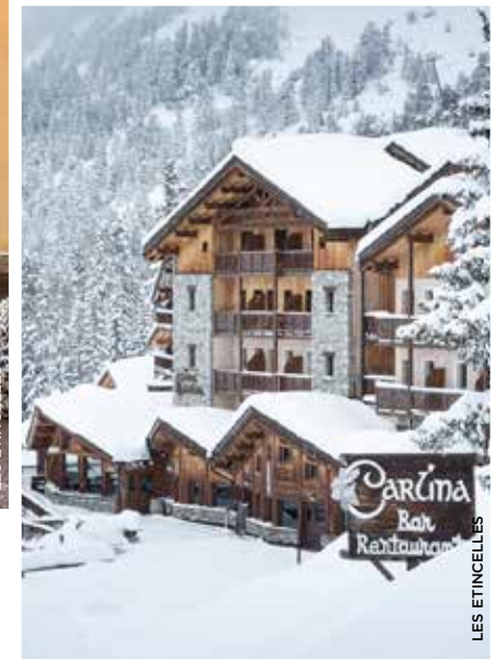
Exemple d'appartement dans les résidences du Village Montana An example apartment in the Village Montana residences
